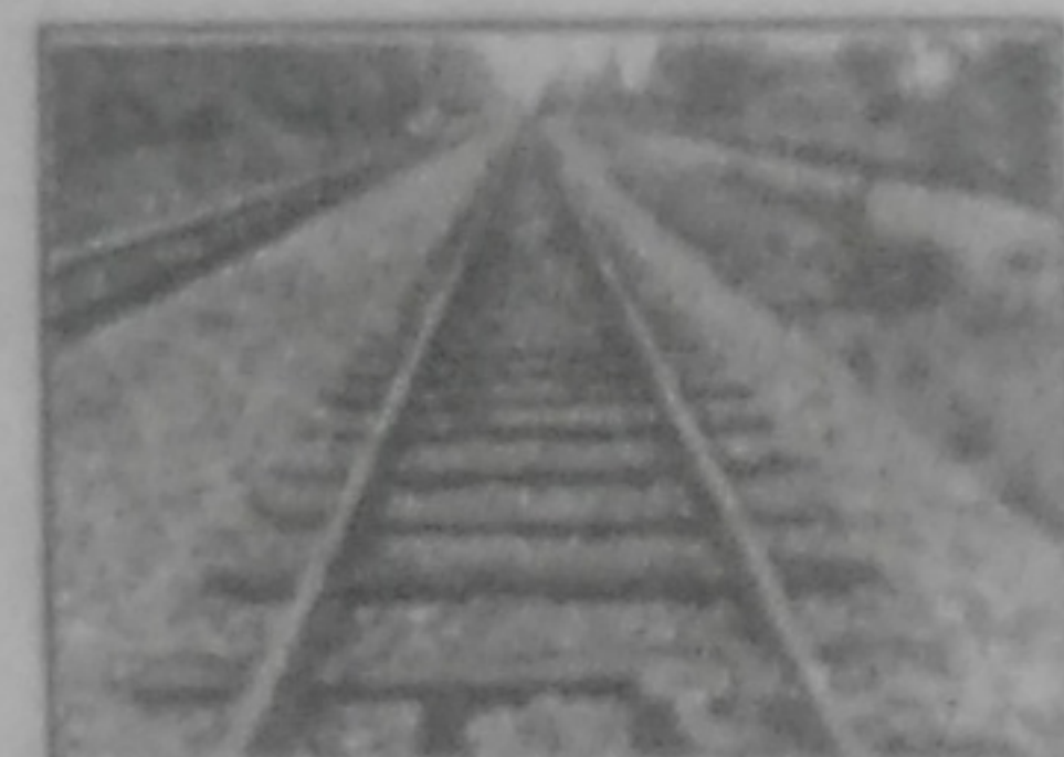
D. 铁轨下铺设枕木
