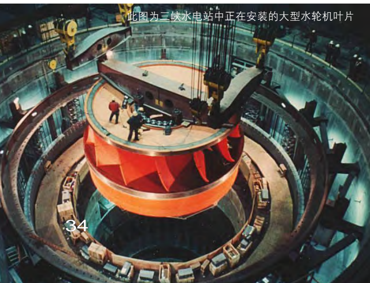
图 17-21 水轮机利用水流驱动发电机转子转动
