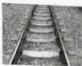
在铁轨下面铺枕木
